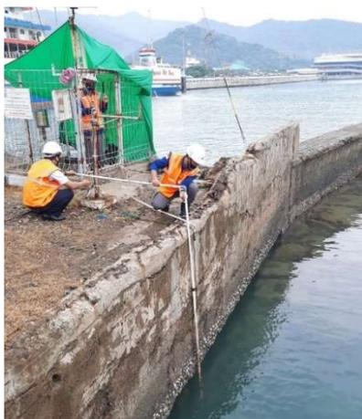
Gambar 7. Pemasangan Sensor *Water level*
